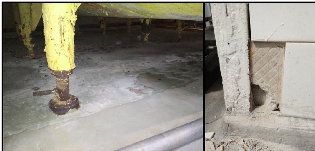
Рис. 5. Состояние пола (слева) и колонны (справа)
